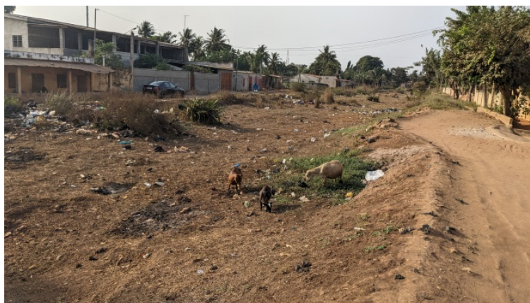
Source : travaux de terrain, 2023 Photo 1 : Voie détruite dans la commune Golfe 5
