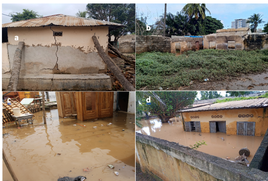
Photo Kouley, 2023 Planche 1 : Destruction des habitations par l'inondation
